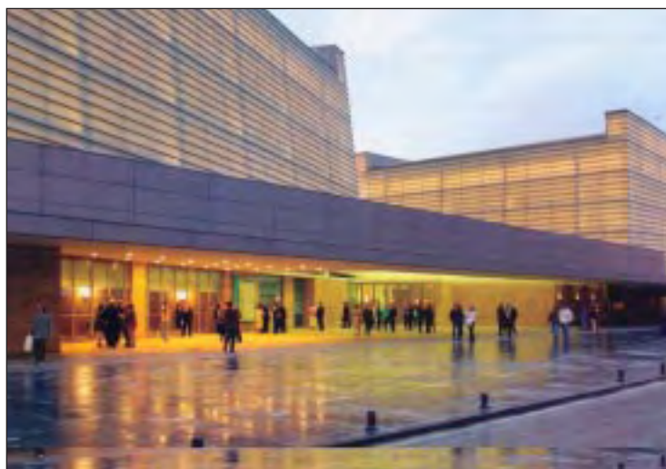
Fachada del centro de congresos Kursaal, en San Sebastián
